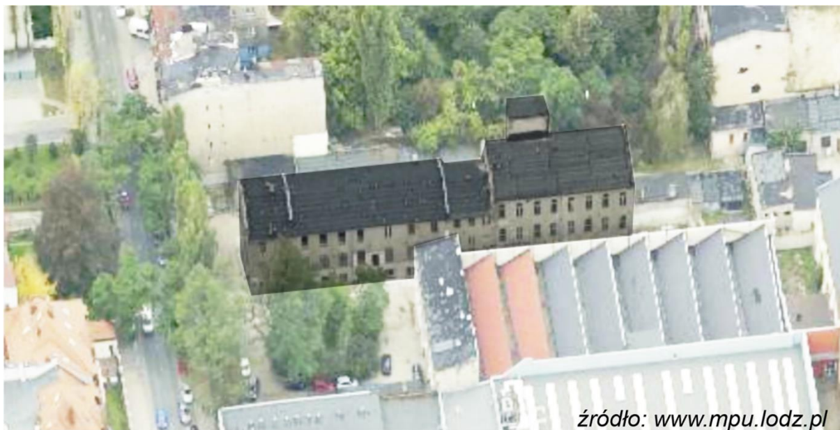
Elewacja budynków przy ul. Rewolucji 1905 r. nr 78/80 w Łodzi
